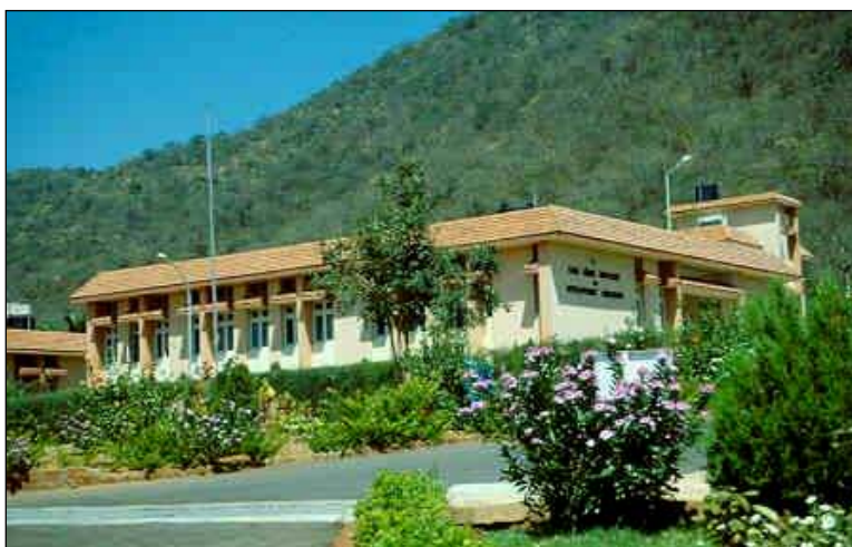
Foto: Verwaltungsgebäude des Karl Kübel Institute for Development Education in Südindien
